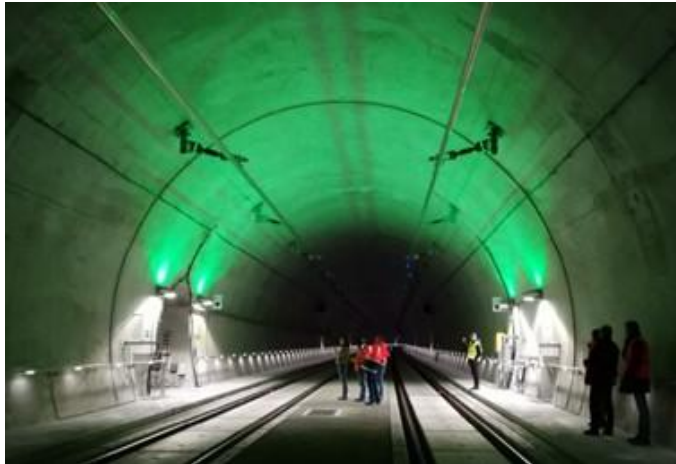
Obrázek 2 - Příklad kruhového osvětlení (dle předpisu RW 10.01.09)
